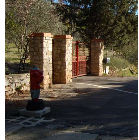
^ Les portails et accès maçonnés
