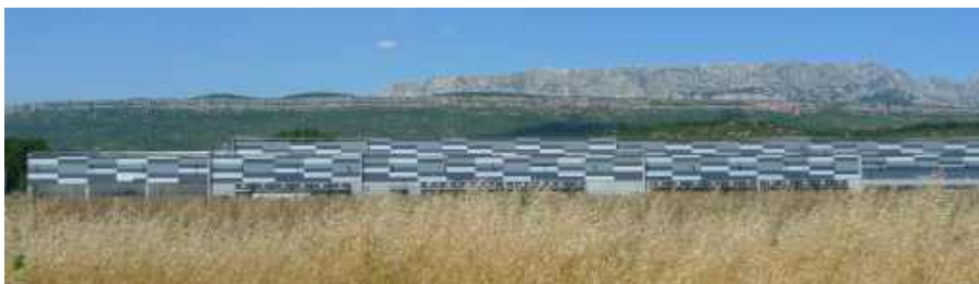
▲ La plateforme logistique à Rousset
