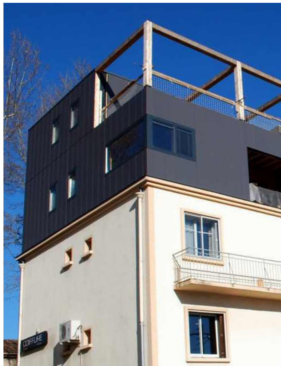
▲ Surélévation en bois au Pont de l'Arc réalisée en 2011 par une entreprise locale
