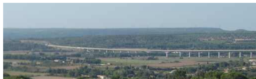
^ Le pont ferroviaire de la ligne LGV passant dans la plaine agricole de la Touloubre
