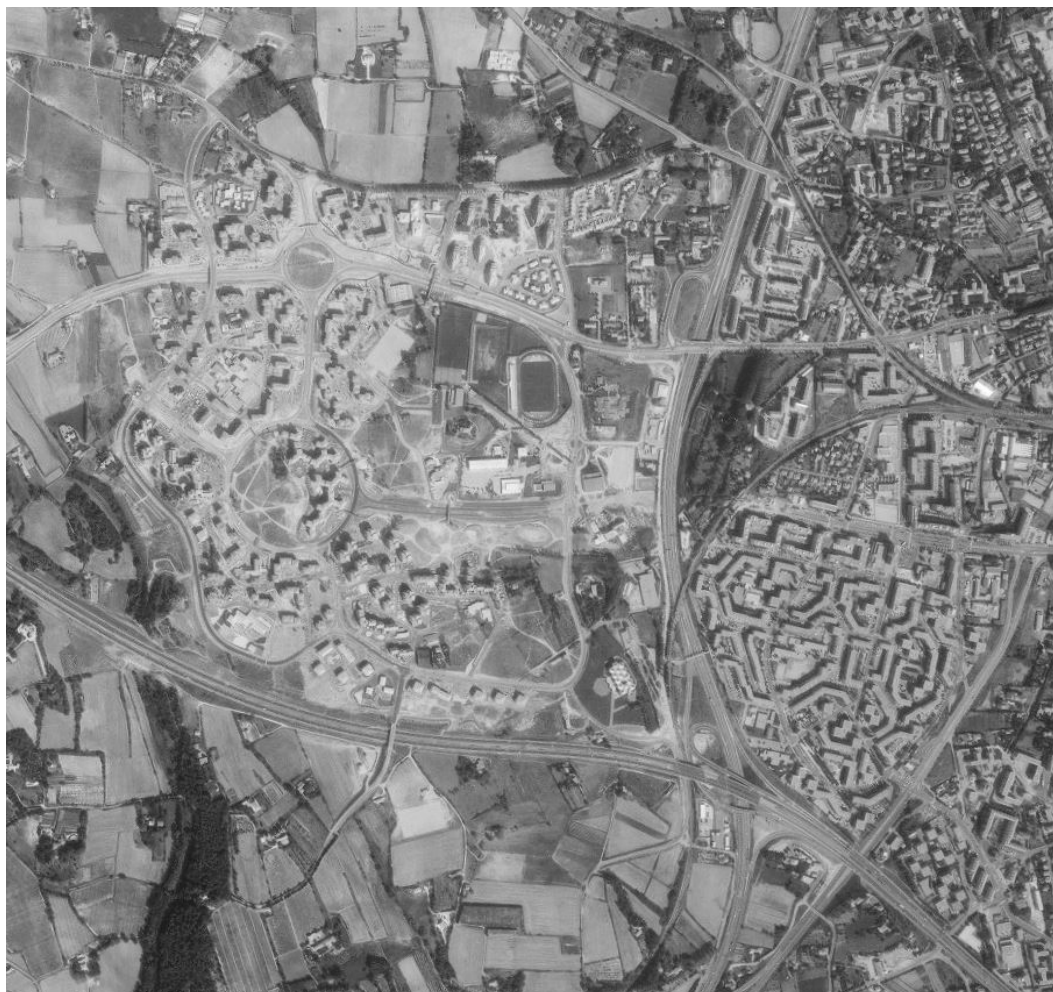
▲ La ZAC du Jas de Bouffan en construction à Aix-en-Provence - 1978
