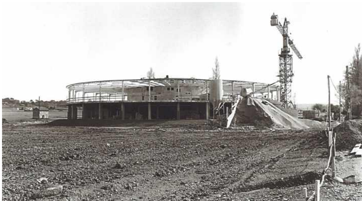
▲ Construction de l'immeuble du CETE (actuel CEREMA) au Pôle d'activités d'Aix-en-Provence - 1969
