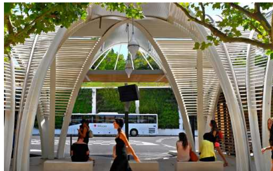
▲ Gare routière d'Aix-en-Provence livrée en 2014
