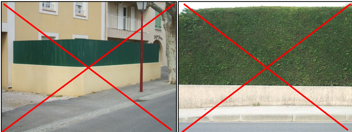
Exemple de clôture proscrite sur domaine public (grillage doublé d'une bâche PVC opaque, hauteur supérieur à 2,00 m, etc.)
