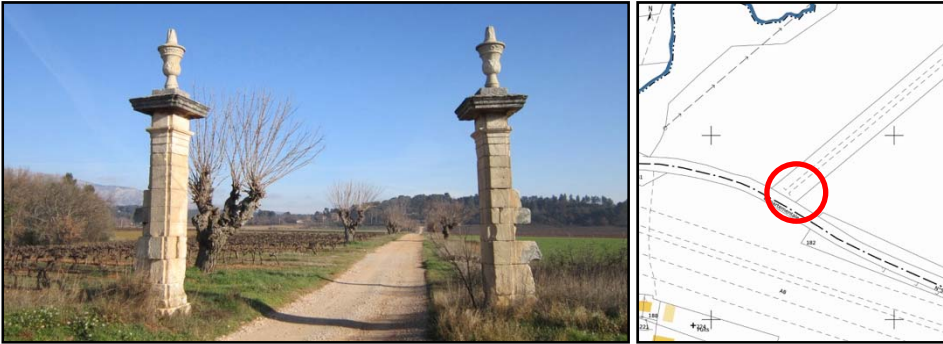
Portail, parcelle AS 223, Lieudit Le Défend
