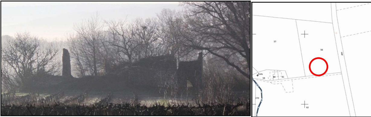
Ruines, parcelles AM 60 et 61, lieudit La Bégude
