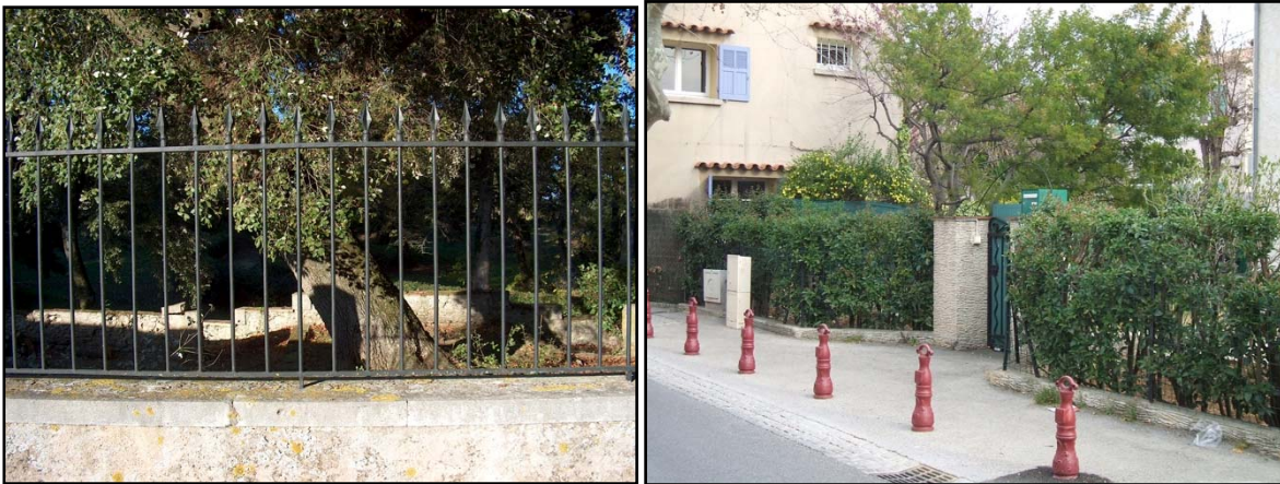
Exemple de clôture autorisée sur domaine public (mur bahut surmonté d'une grille, clôture grillagée doublée d'une haie végétale,...)
