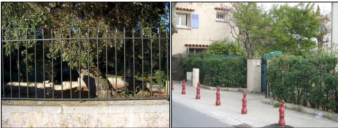
Exemple de clôture autorisée sur domaine public (mur bahut surmonté d'une grille, clôture grillagée doublée d'une haie végétale,...)
