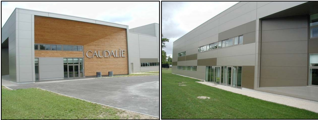
Exemples de revêtement de façade autorisés (1ère photo : bardage métal en combinaison avec bardage bois)
