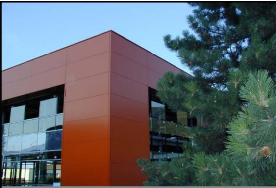
Exemple (toitures et équipements masqués par un acrotère)
