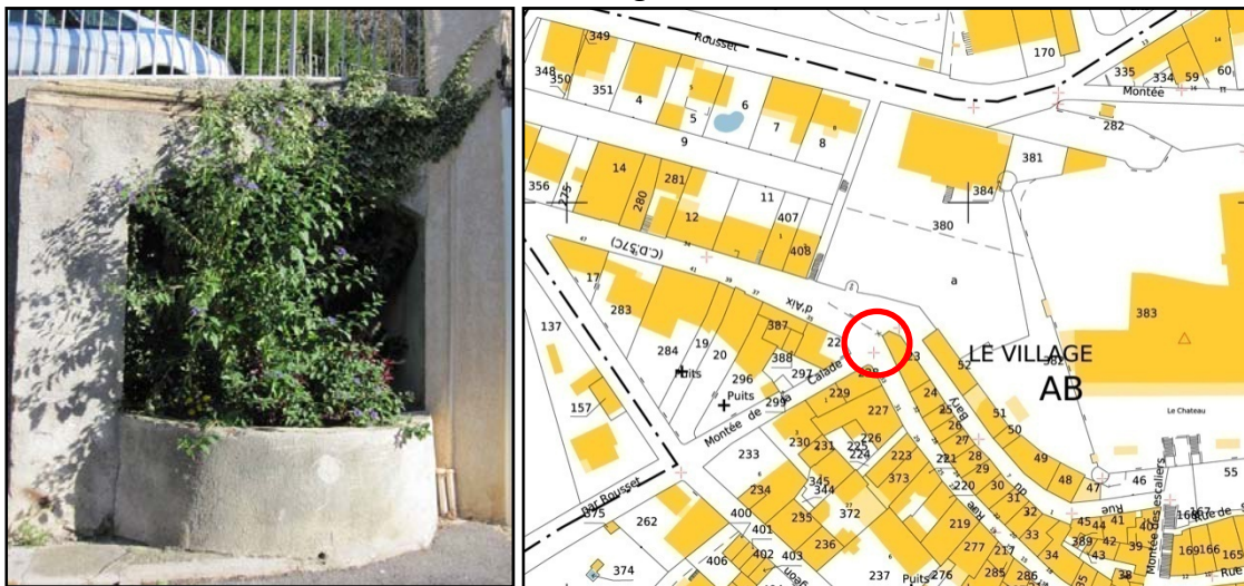
Fontaine du Christ, rue d'Aix, lieudit Le Village
