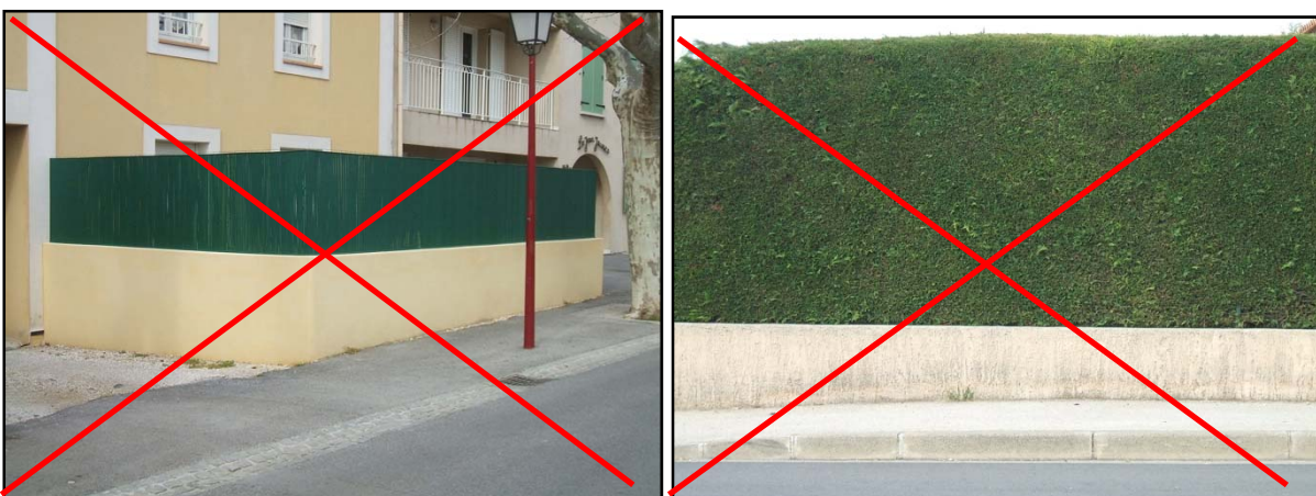
Exemple de clôture proscrite sur domaine public (grillage doublé d'une bâche PVC opaque, hauteur supérieur à 2,00 m, etc.)
