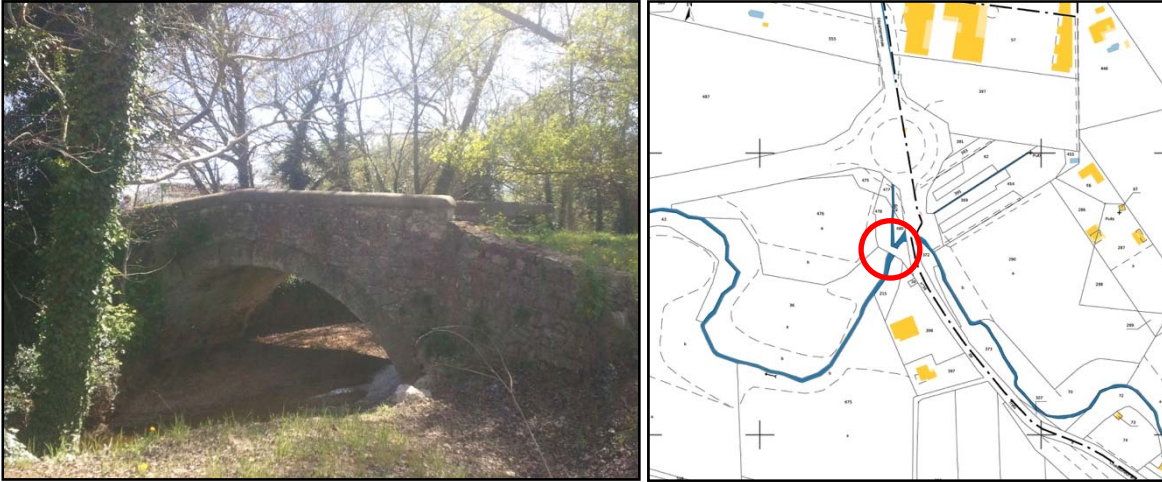
Ancien pont sur l'Aigue Vive, RD 56, lieudit Plantier
