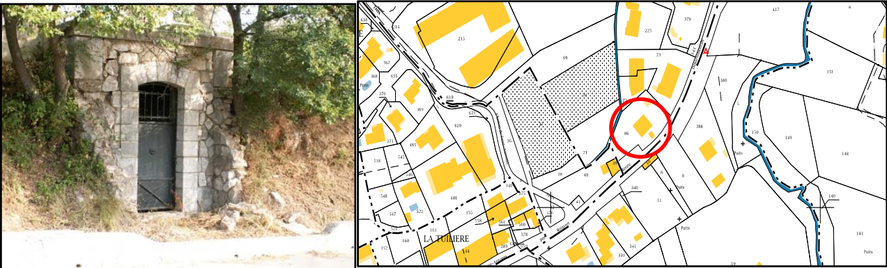
Entrée de l'ancien réservoir d'eau, parcelle AE 86
